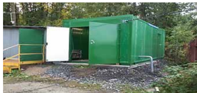
Рисунок 3. Внешний вид здания компрессорной станции, построенного на водозаборе-аналоге
