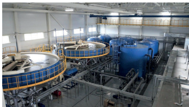
Рисунок 6. Флотационная очистка стоков жиропроизводства
