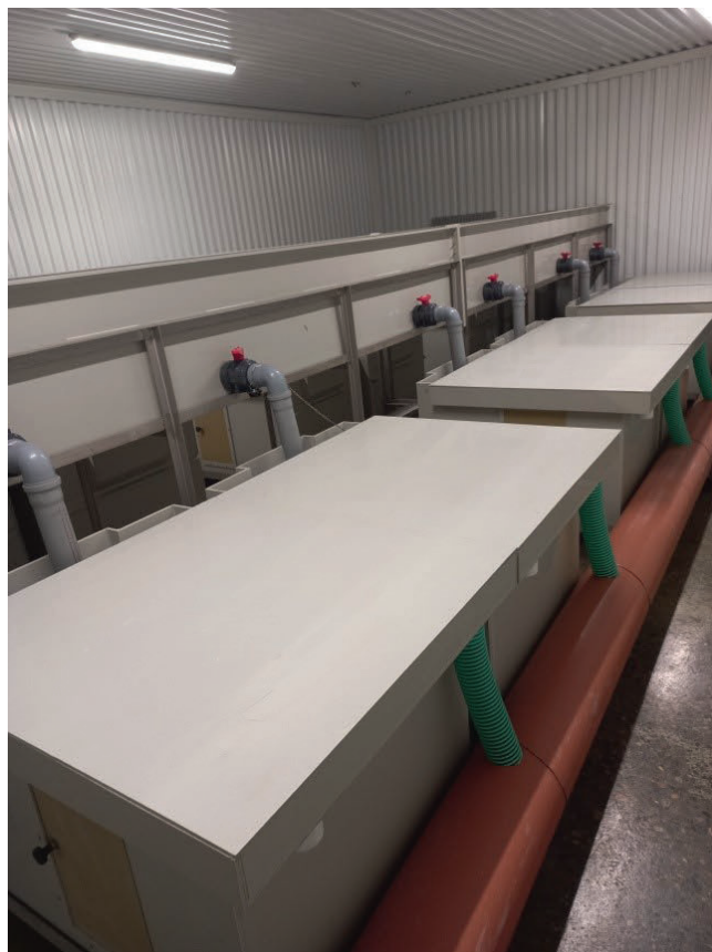
Рисунок 2. Аппараты гравийного типа, установленные в ИПЦ Тахтоямского ЛРЗ (вверху фото – сеть интернет, внизу – фото А.А. Оглы)
