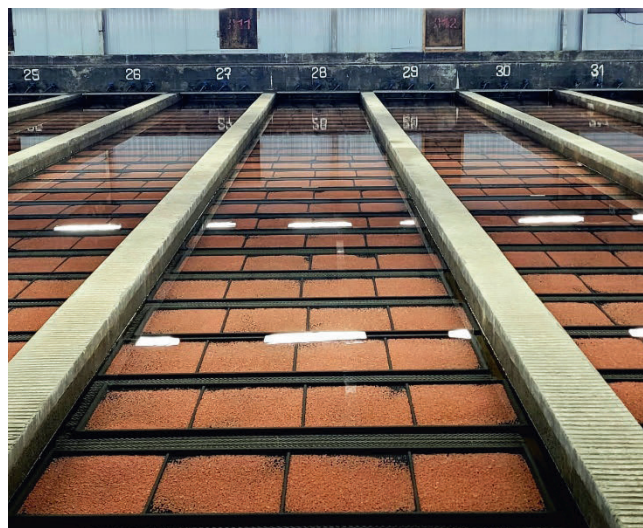
Рисунок 2. Пример бетонных каналов, в которых на рыболовных заводах Сахалинской области выращивают молодь тихоокеанских лососей. Постановка на выклев икры кеты на пластиковых поддонах Figure 2. An example of concrete channels in which juvenile Pacific salmon are grown at fish hatcheries in the Sakhalin Region. Hatching of chum salmon eggs on plastic pallets
